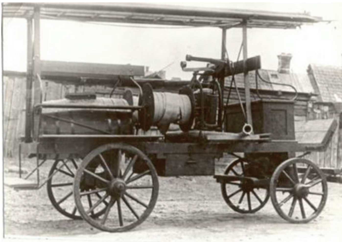
Пожарный ход с лестницей
