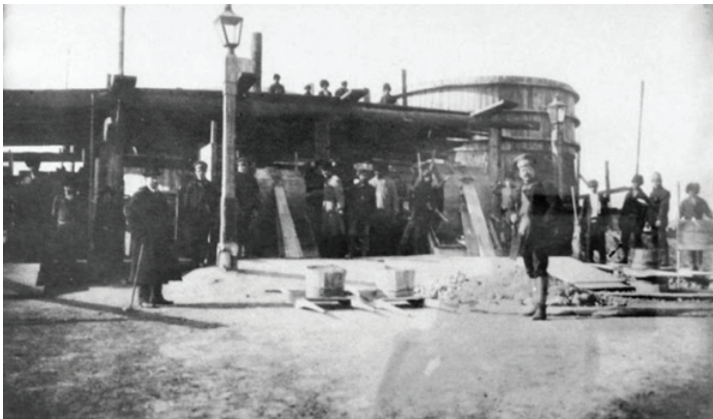
Строительство пожарного резервуара в Николаевской слободе
