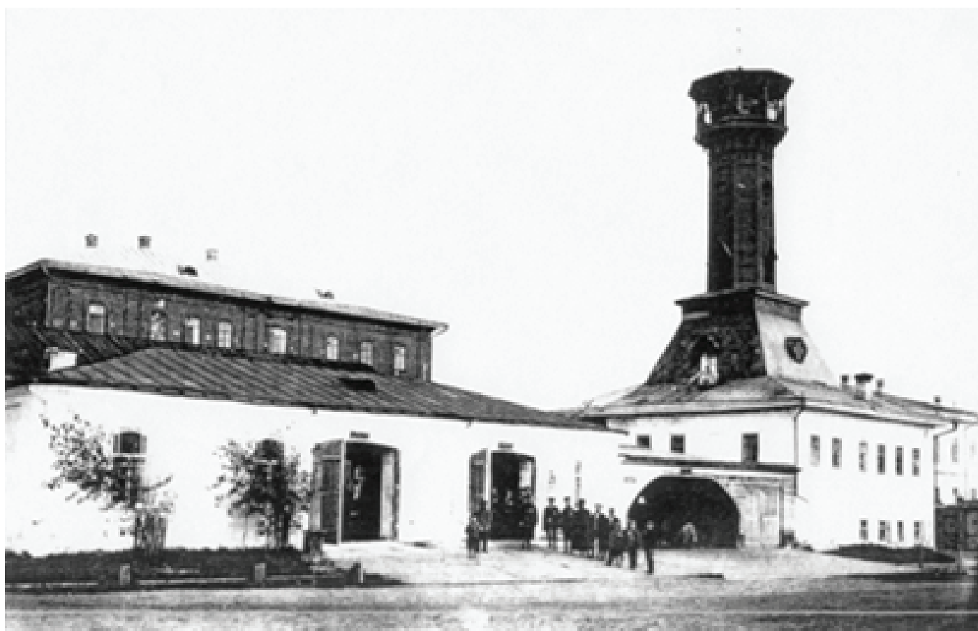
Пожарное депо г. Енисейска
