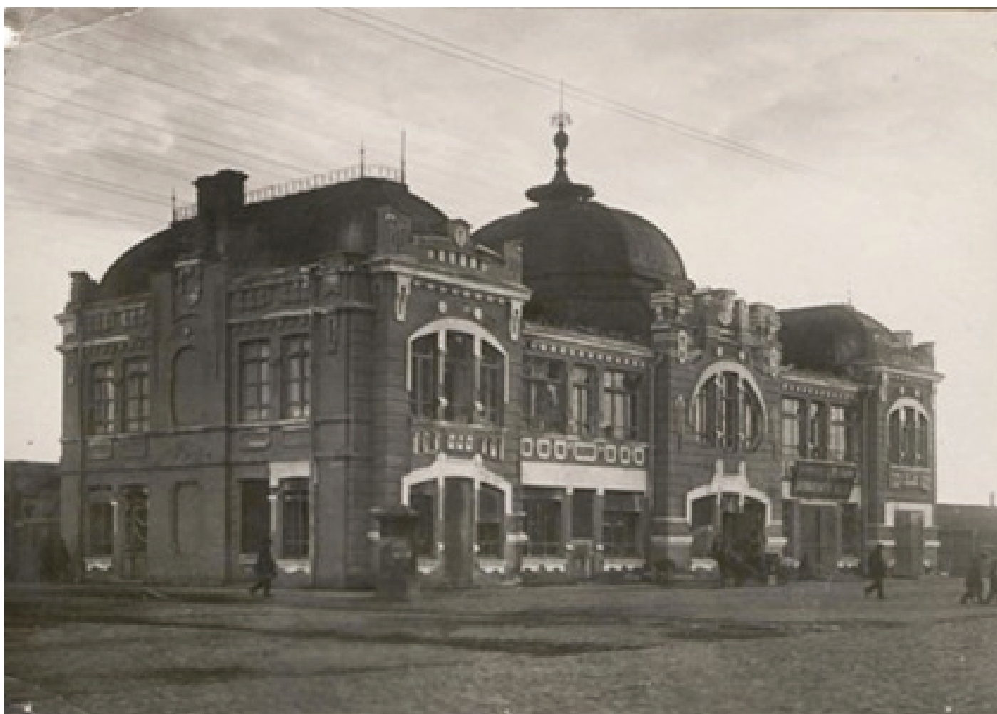
Пожарное депо на Новобазарной площади г. Красноярска
