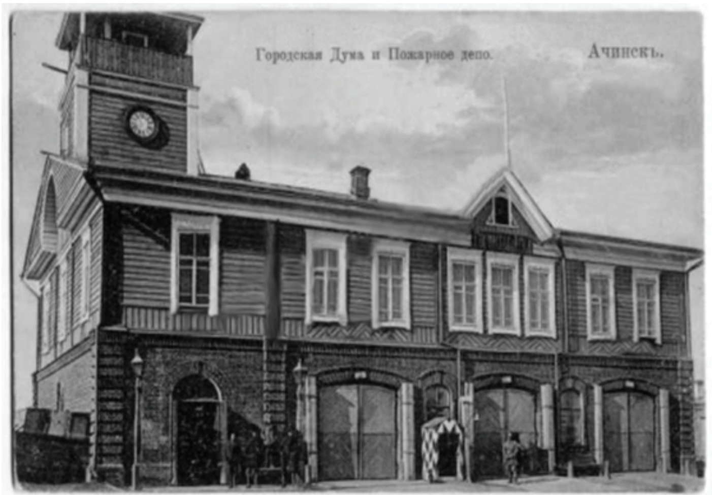
г. Ачинск – Городская Дума и пожарное депо
