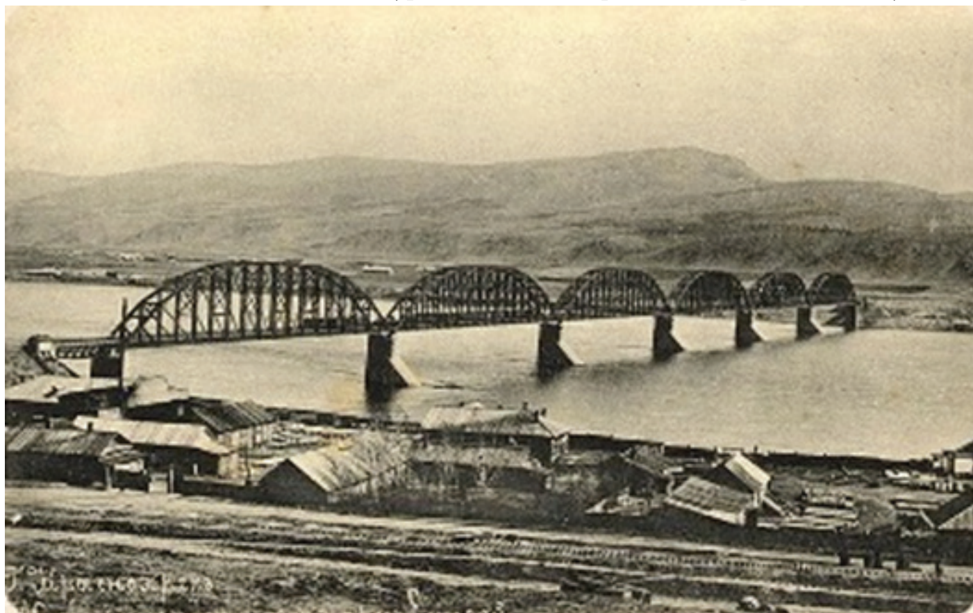
Железнодорожный мост через р. Енисей
